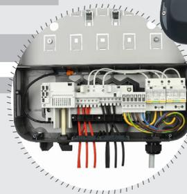
\* Contém DPS, chave de seccionamento e porta fusível integrado.
